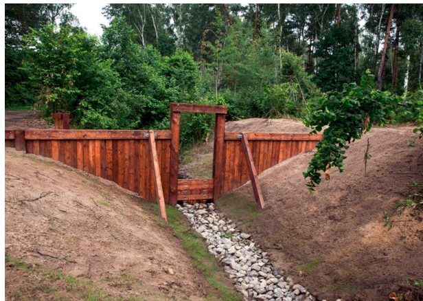
Ryc. 2. N-ctwo Lubaczów - drewniana zastawka na rowie melioracyjnym (źródło: http://www.ckps.lasy.gov.pl )
