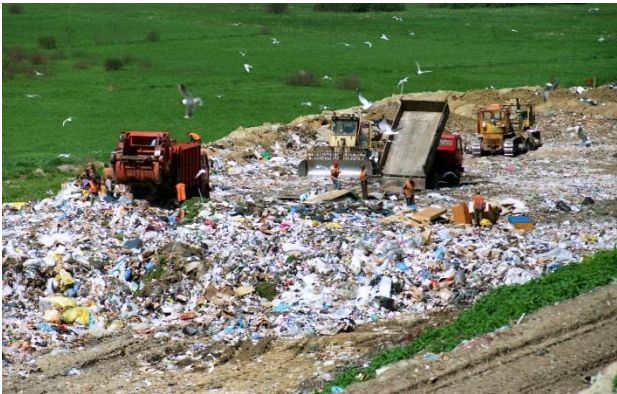
Ryc. 2. Mimo zapotrzebowania na nowoczesne i bezpieczne miejsca składowania odpadów, budowa i wdrożenie tego typu obiektów wymaga szeregu analiz, zarówno środowiskowych jak i społecznych [źródło: Wikipedia].
